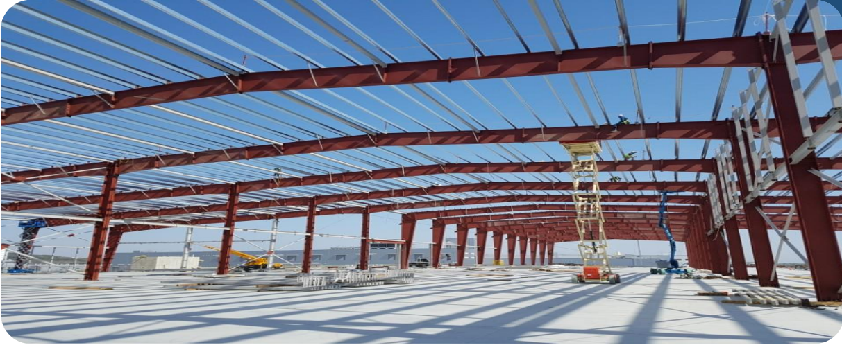
AK인천국제물류센터 신축공사 중 PEB 철골공사
