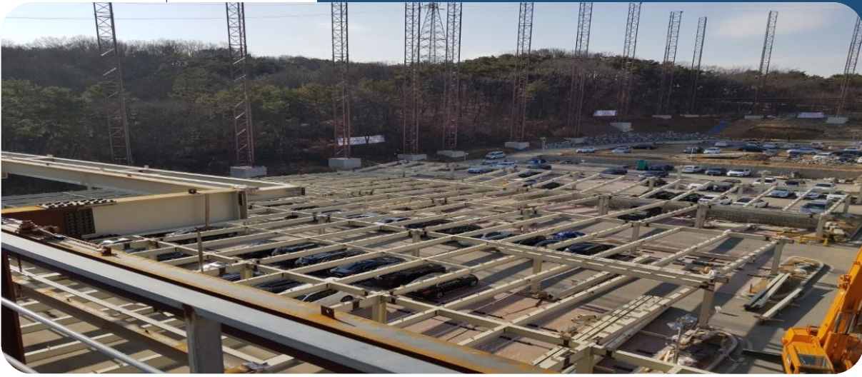
오성 고등학교 조례대 환경개선공사 중 철골공사
