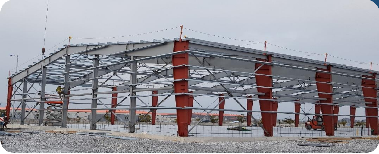
광양냉장(주) 창고시설 신축공사 중 철골공사
