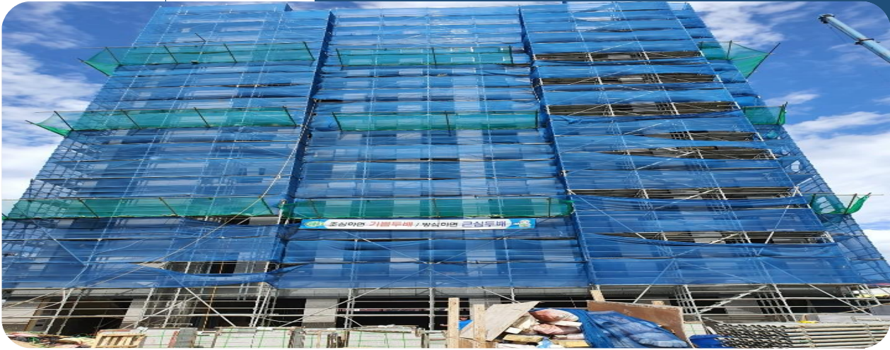
내장리 문화시설 신축공사 중 철골공사
