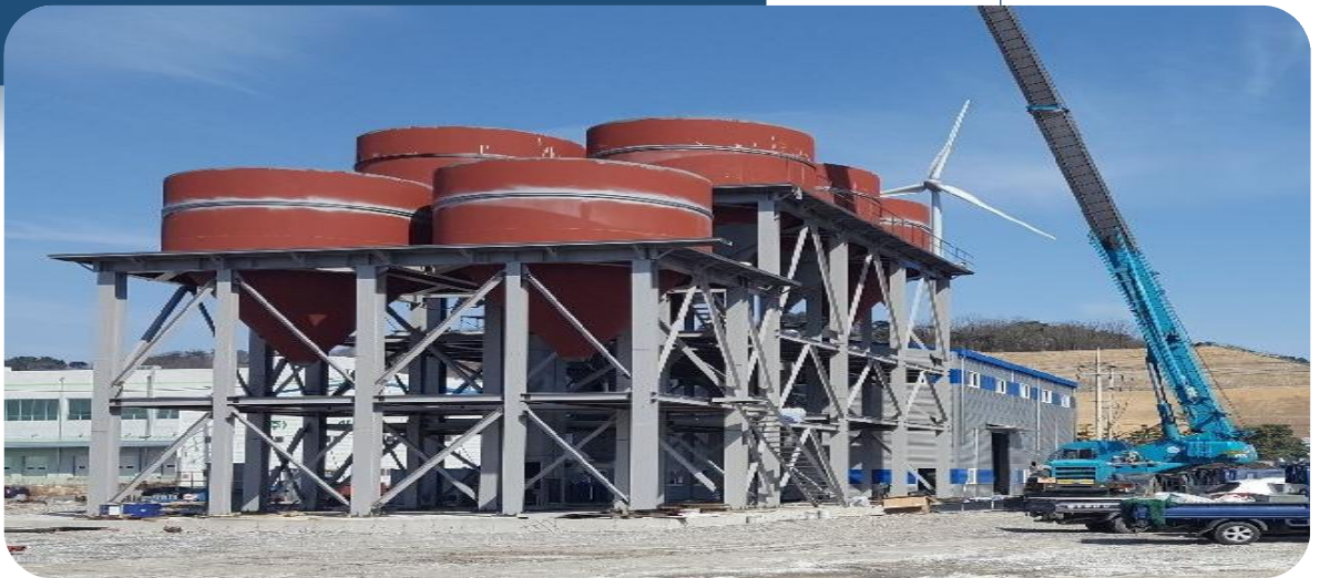
경주 강동공장 신축공사 중 SILO 제작/설치
