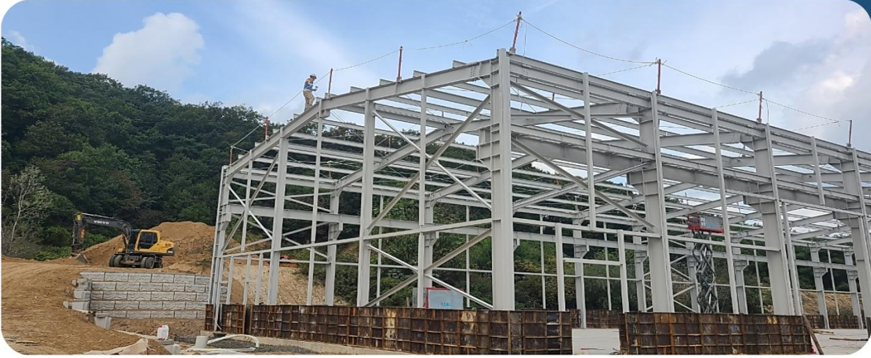
(주)대신티앤에스 여주공장 신축공사 중 철골공사
