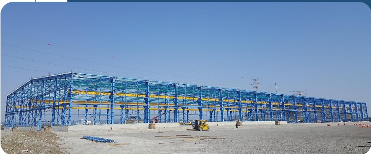
(주)코스틸 포항1공장 B-BLOCK 공장동 증축공사 중 철골공사
