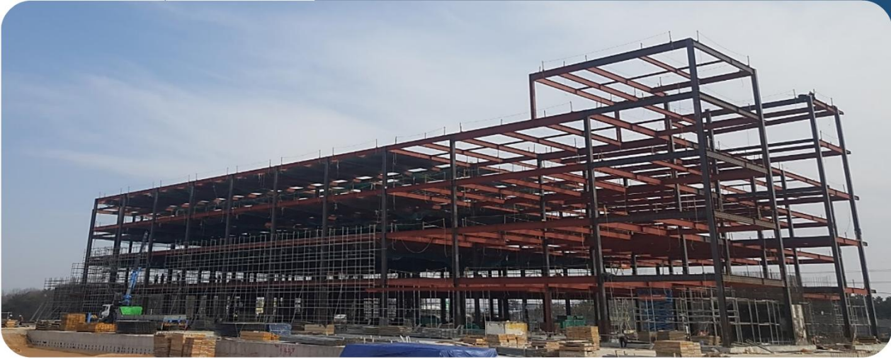
(주)코스틸 포항1공장 B-BLOCK 공장동 증축공사 중 철골공사
