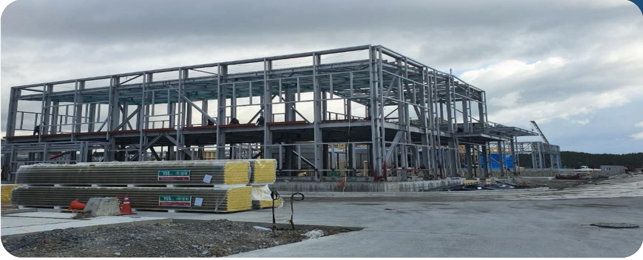
BRP신축공사(건축,토목,건축설비) 중 철골공사
