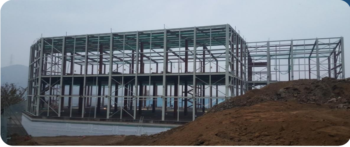
(주)이스트 밸리티엔텍 경주공장 증축공사 중 철골공사
