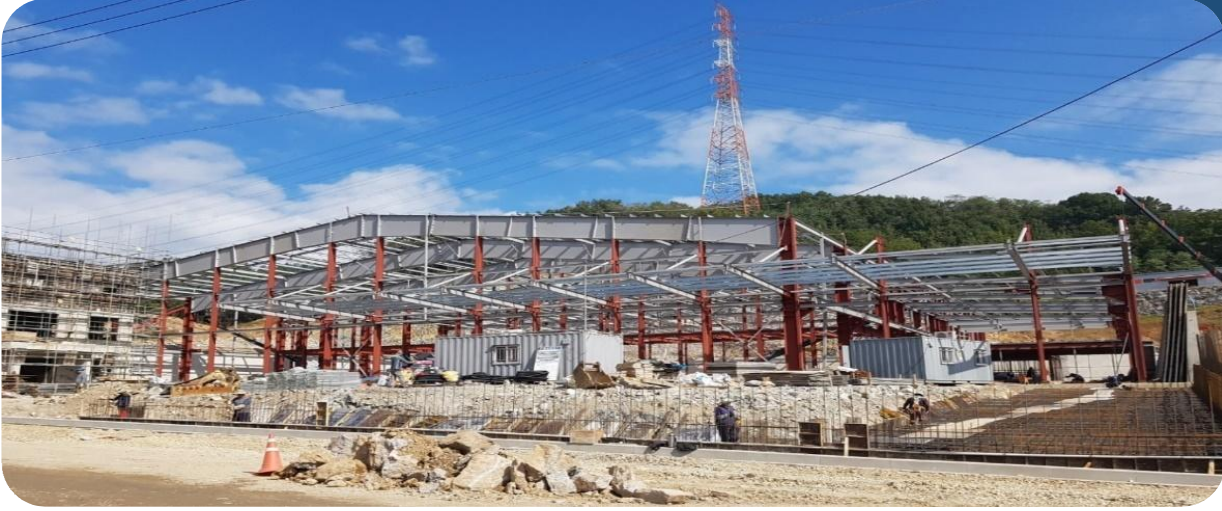
옥포면 교항리 주차장 및 근린생활시설 신축공사 중 철골공사
