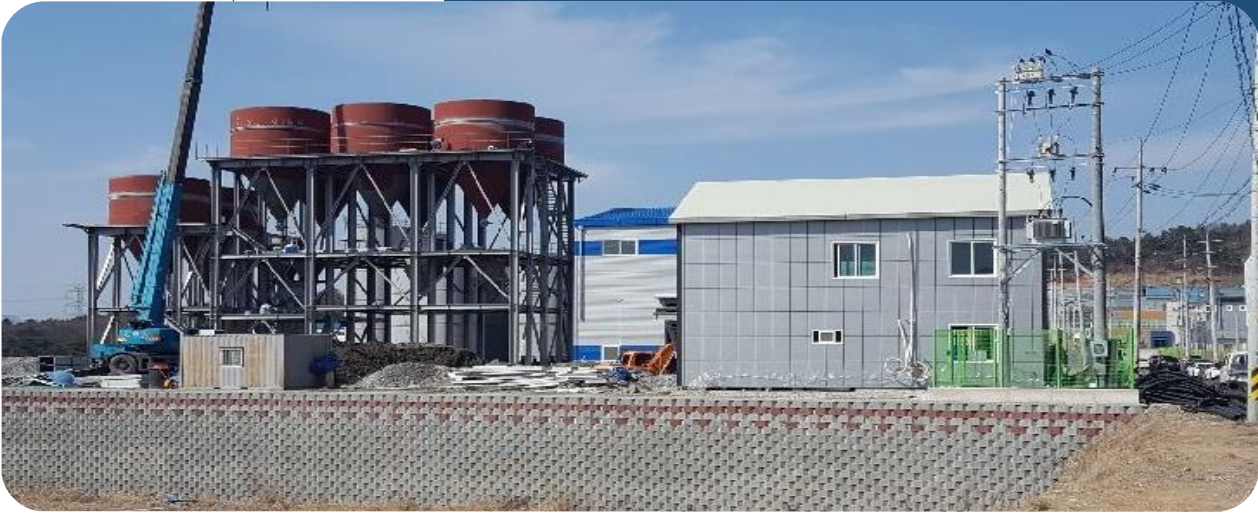
경주 강동공장 신축공사 중 SILO 제작/설치
