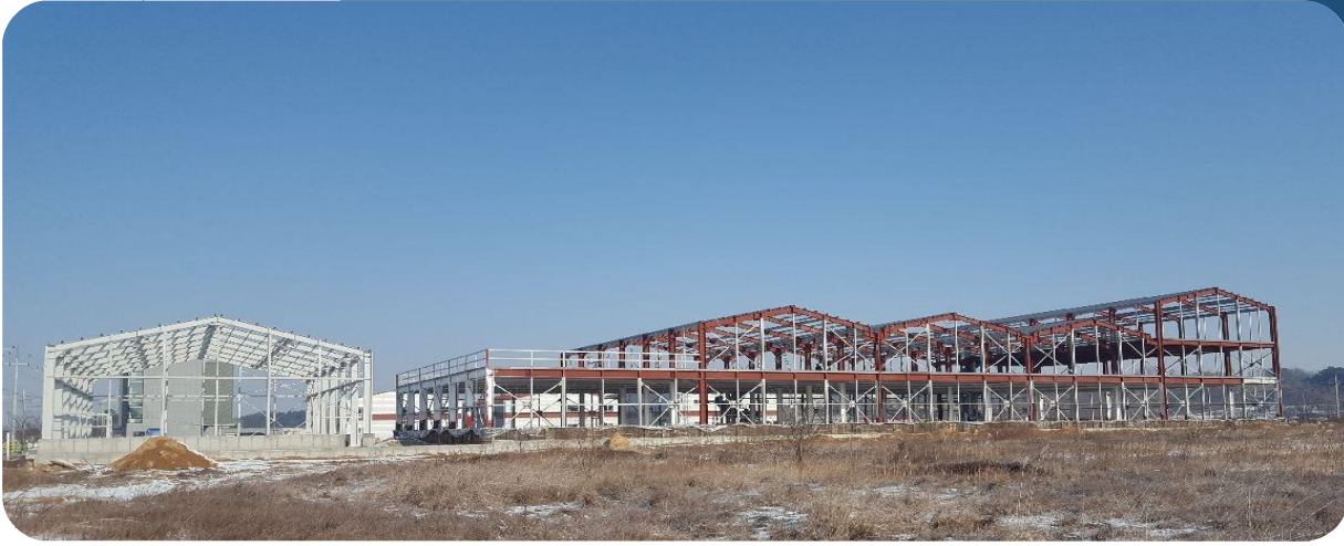
신호인더스트리 예당산단 3공장 신축공사 중 철골공사
