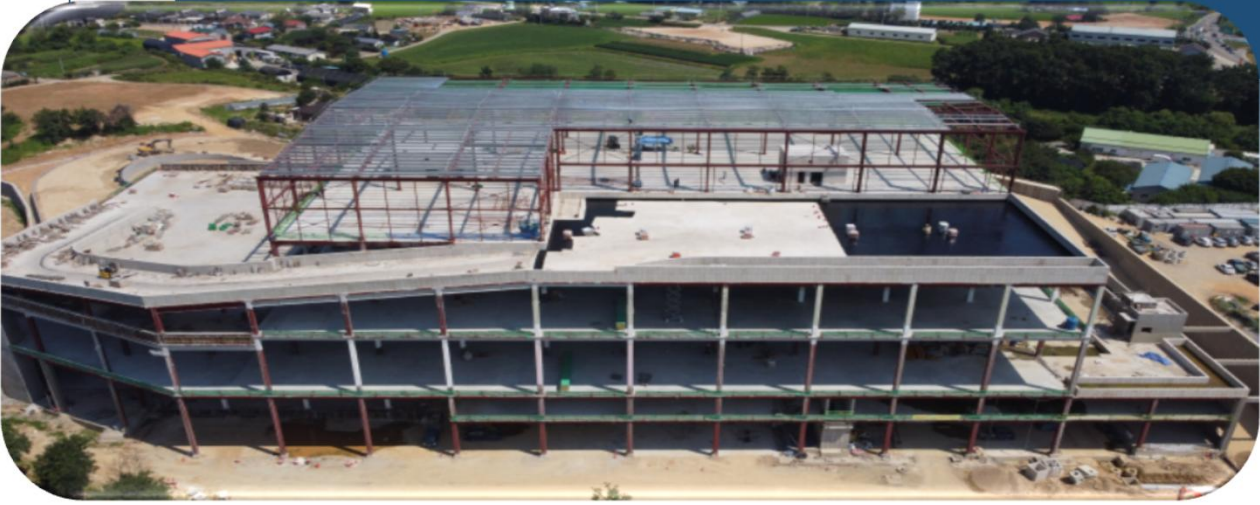
이천시 백사면 엠큐 물류센터 신축 철골공사 (합성보 ACT+TSC+PEB)
