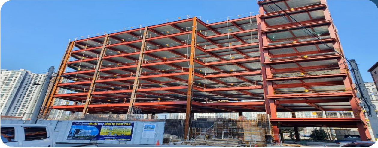
대구 상록 주택재개발 정비사업공사 중 철골공사
