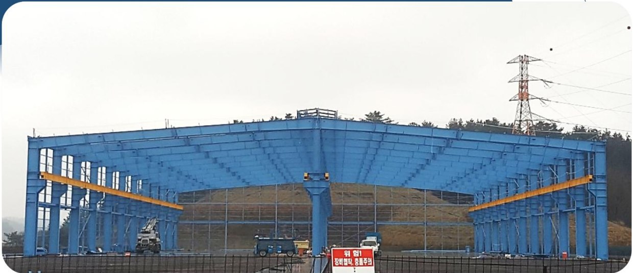
(주)코스틸 포항1공장 B-BLOCK 공장동 증축공사 중 철골공사
