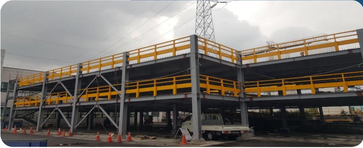
평창무역 광양항 창고시설 신축공사 중 철골공사
