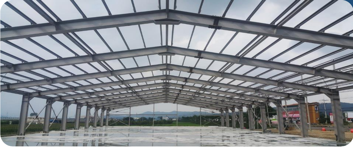
이.푸드 총주공장 신축공사 중 철골공사
