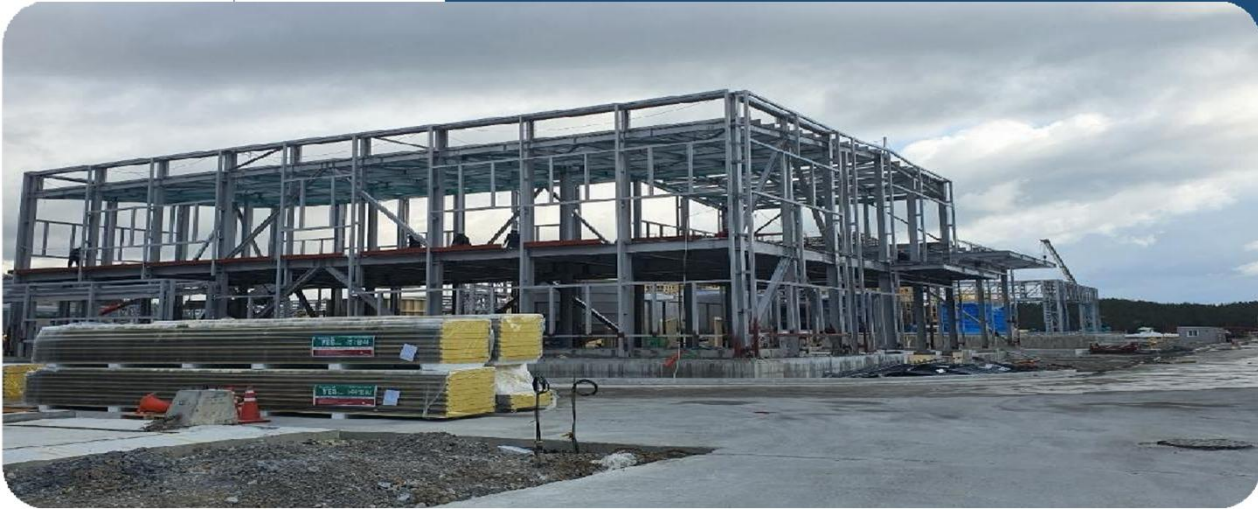
BRP신축공사(건축,토목,건축설비) 중 철골공사
