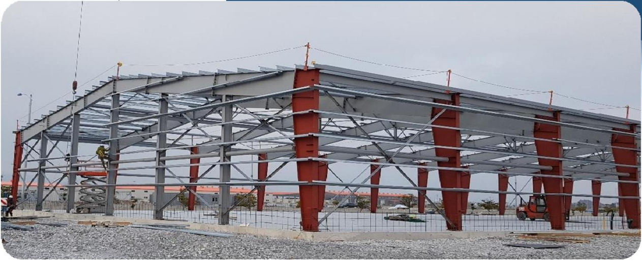
광양냉장(주) 창고시설 신축공사 중 철골공사
