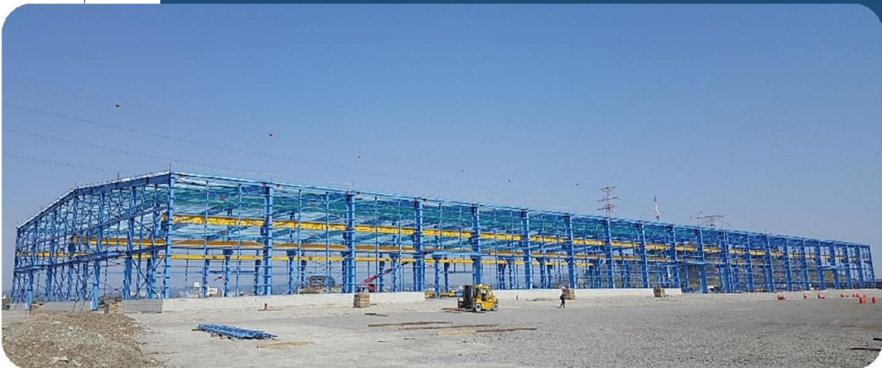
(주)코스틸 포항1공장 B-BLOCK 공장동 증축공사 중 철골공사
