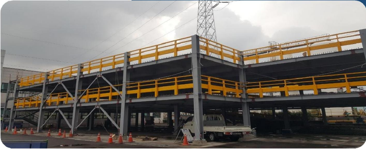
평창무역 광양항 창고시설 신축공사 중 철골공사
