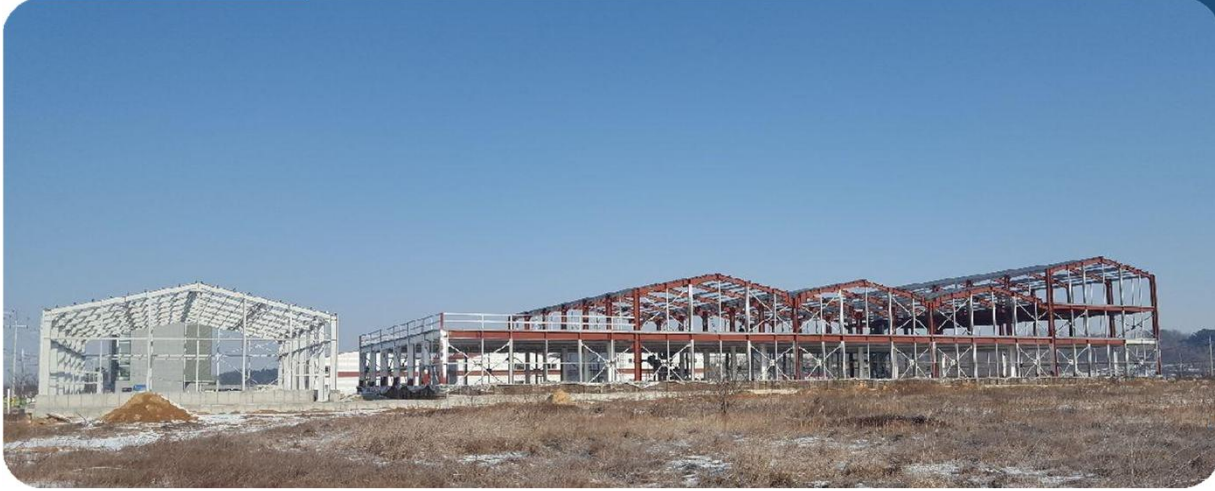
신호인더스트리 예당산단 3공장 신축공사 중 철골공사
