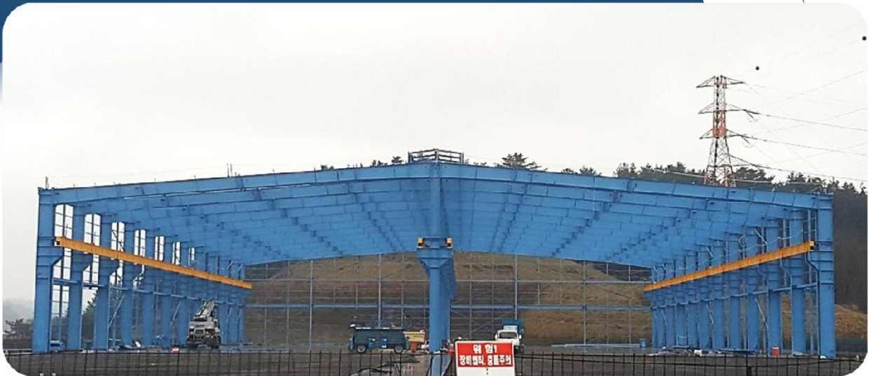
(주)코스틸 포항1공장 B-BLOCK 공장동 증축공사 중 철골공사
