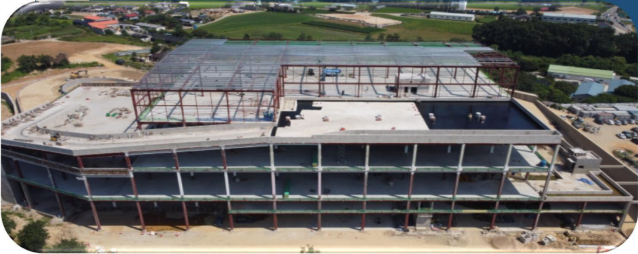
천시 백사면 엠큐 물류센터 신축 철골공사 (합성철골 ACT+TSC+PEB)
