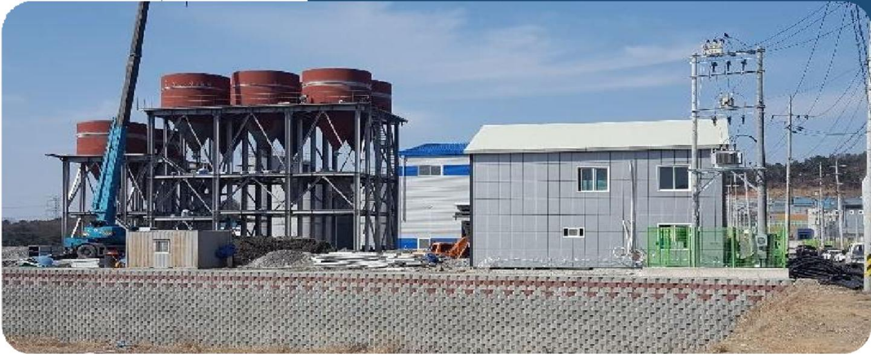
경주 강동공장 신축공사 중 SILO 제작/설치
