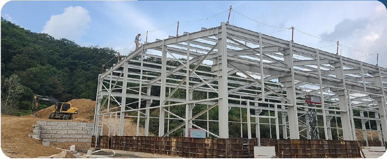
(주)대신티앤에스 여주공장 신축공사 중 철골공사
