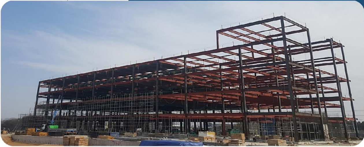
(주)코스틸 포항1공장 B-BLOCK 공장동 증축공사 중 철골공사
