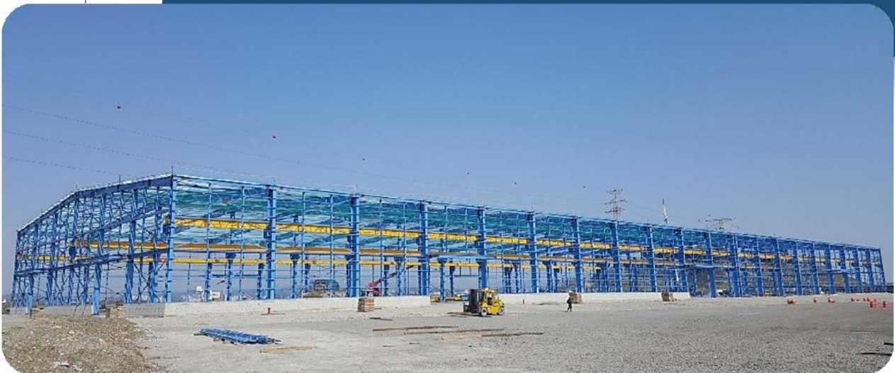
(주)코스틸 포항1공장 B-BLOCK 공장동 증축공사 중 철골공사
