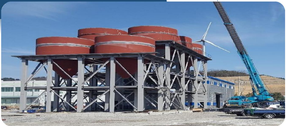
경주 강동공장 신축공사 중 SILO 제작/설치
