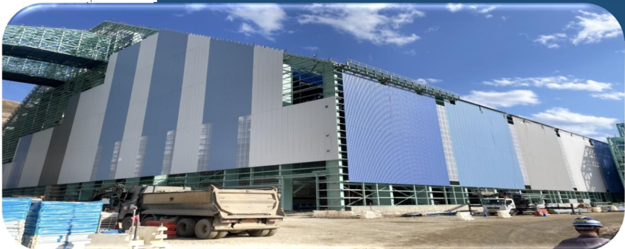
양소 원료야드 밀폐화 선형 Shed 강구조물 공사(PEB+ROLL)
