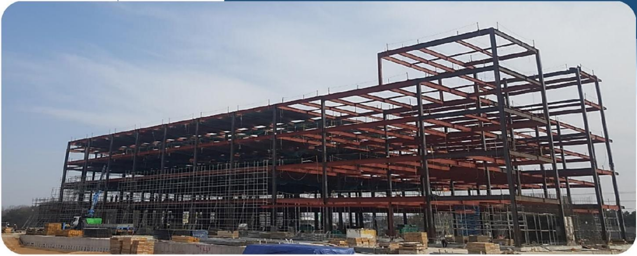
(주)코스틸 포항1공장 B-BLOCK 공장동 증축공사 중 철골공사
