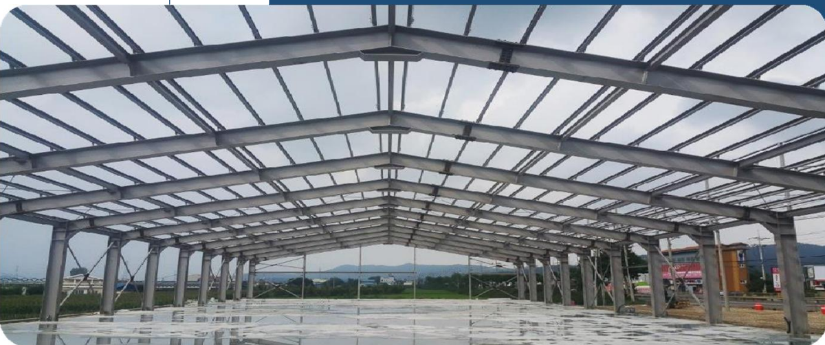
청정식품공장 신축공사 중 철골공사
