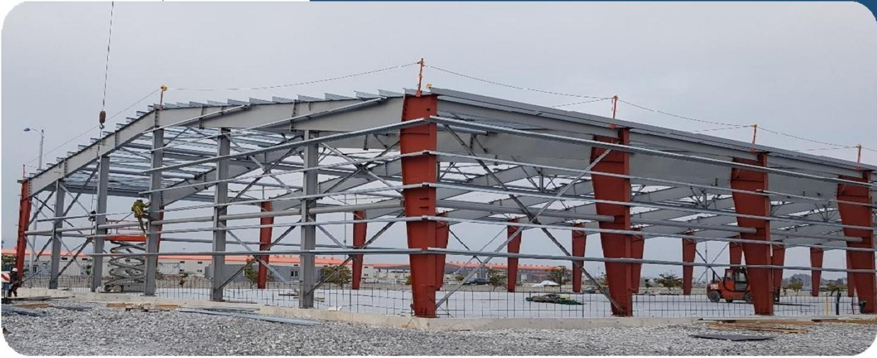
광양냉장(주) 창고시설 신축공사 중 철골공사
