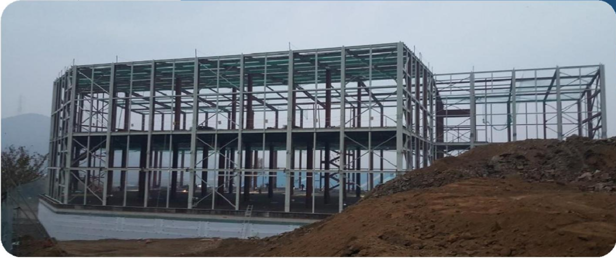
(주)이스트 밸리티엔텍 경주공장 증축공사 중 철골공사
