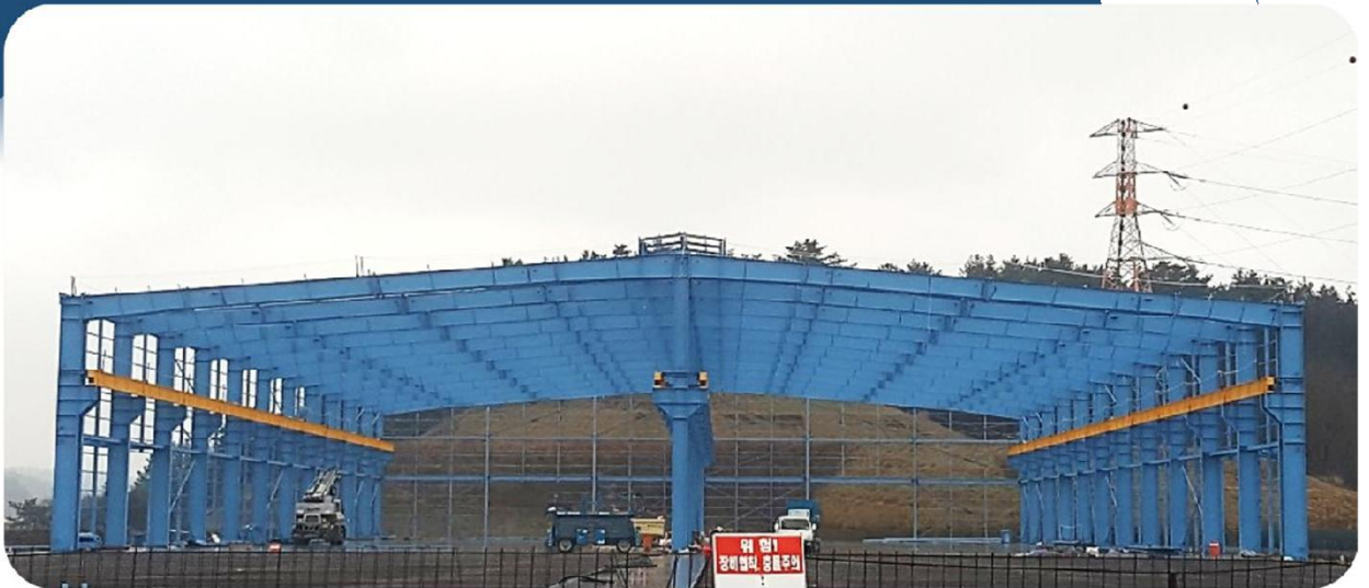
(주)코스틸 포항1공장 B-BLOCK 공장동 증축공사 중 철골공사
