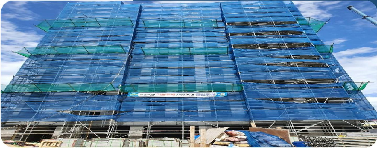
내장리 문화시설 신축공사 중 철골공사
