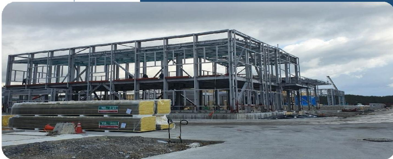
BRP신축공사(건축,토목,건축설비) 중 철골공사
