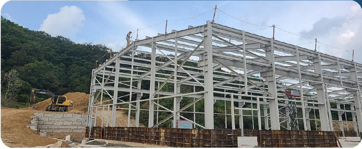
(주)대신티앤에스 여주공장 신축공사 중 철골공사
